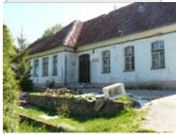
Stan przed przebudową
